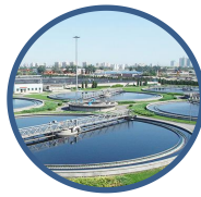
市政、农村污水
