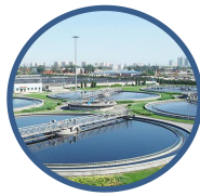
市政、农村污水
